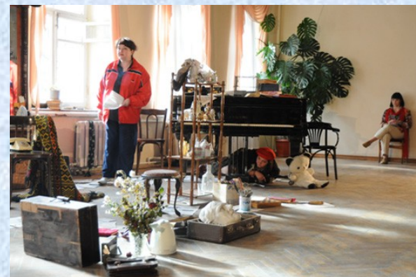
Проведены ремонтные работы в драмтеатре «Бенефис»
